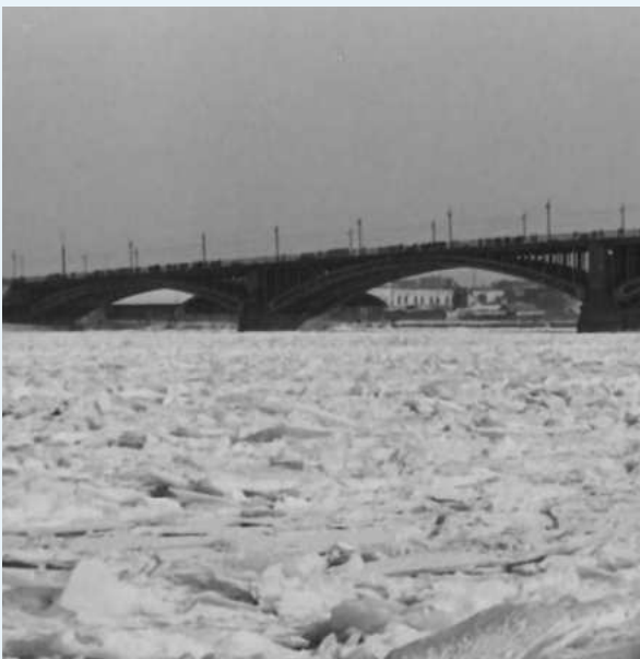
Eisperiode Februar 1956 im Rhein bei Mainz, Blick auf die Straßenbrücke Mainz-Kastel (heute „Theodor-Heuss-Brücke“)
